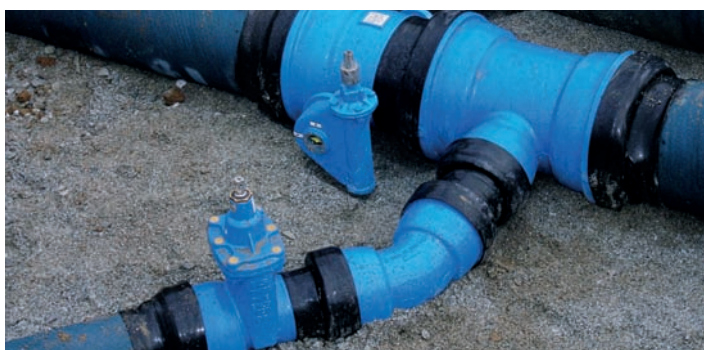
BLS®-Schieberkreuz mit Klappe und Schieber
